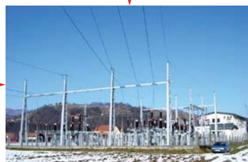
Razdelilna transformatorska postaja - znižanje napetosti na 220 V
